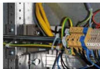
Guide DIN in acciaio e in alluminio, standardizzate secondo norme europee, consentono il montaggio di apparecchiature elettriche modulari e non, all'interno di quadri elettrici.
