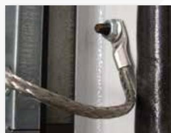
La treccia in rame è utilizzata come conduttore extra flessibile per tutte le necessità di connessioni elettriche compresi collegamenti di potenza, di terra ed equipotenziali.
