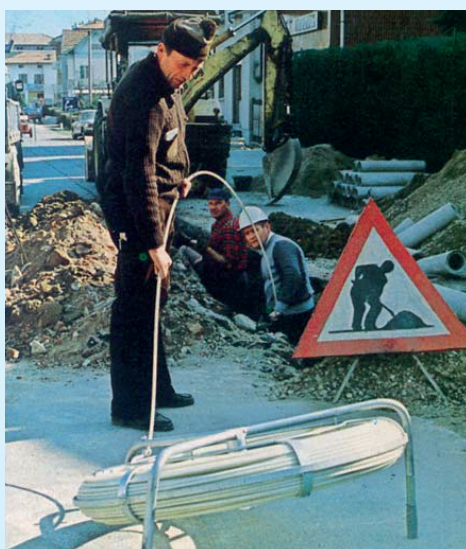
► Foto storica. Confronto delle dimensioni tra una sonda in fibra di vetro con una sonda in piattina d'acciaio, comunemente usata negli anni '80. Historic photo. A comparison between the dimensions of a glassfiber fishtape and a flat steel fishtape commonly used in '80s.
